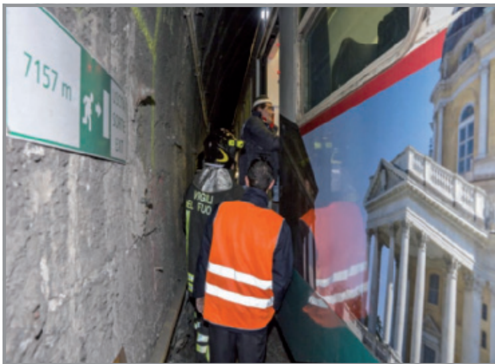
Esercitazione di protezione civile nel Tunnel del Frejus 2017. La larghezza della banchina con un treno passeggeri mette in evidenza l'ineduguatezza dell'infrastruttura e l'incompatibilità con le sagome dei treni merci.
