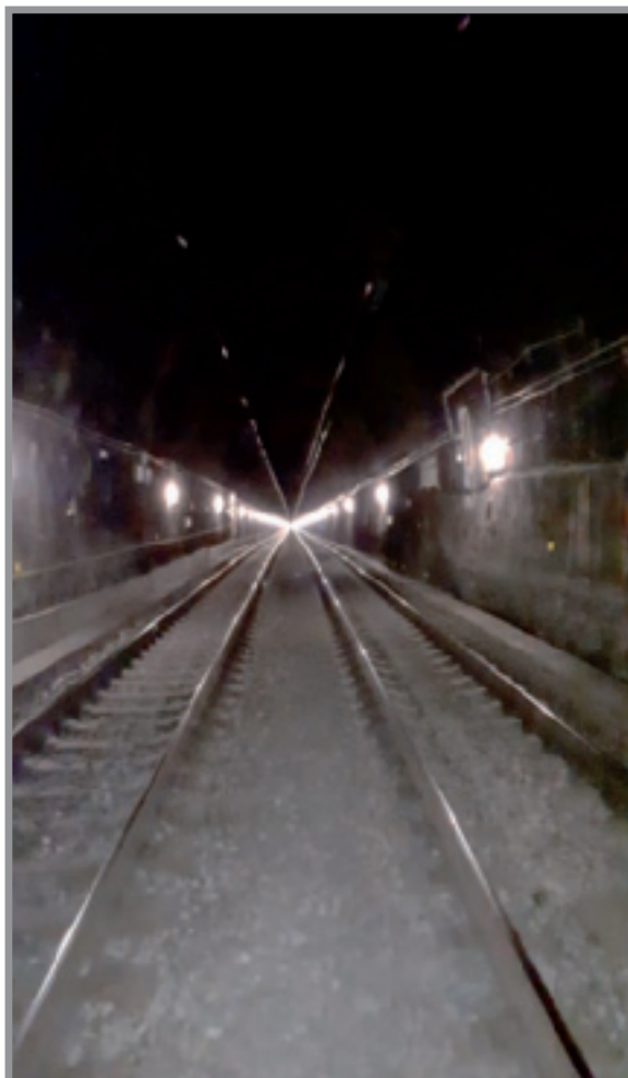
Il Tunnel del Frejus dal confine di stato in direzione Francia
