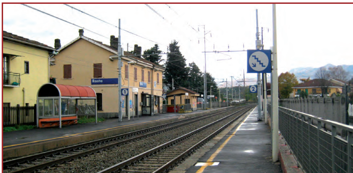
Fig. 23 – La stazione di Rosta vista dai binari.
