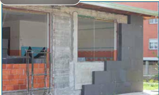
Setti in cemento armato per miglioramento statico e pannelli di coibentazione
