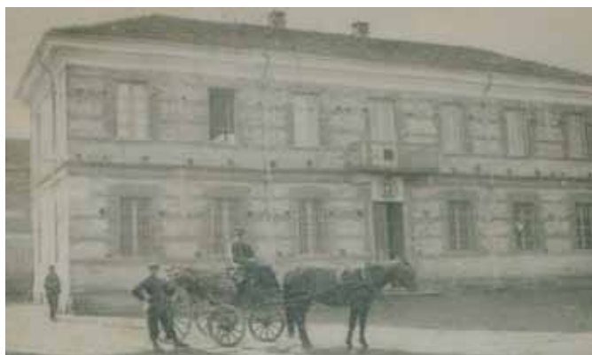
Immagine storica dell'edificio oggetto di intervento
